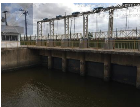
Figura 2: Barragem do Bacanga Fonte: Próprio autor- 2020
